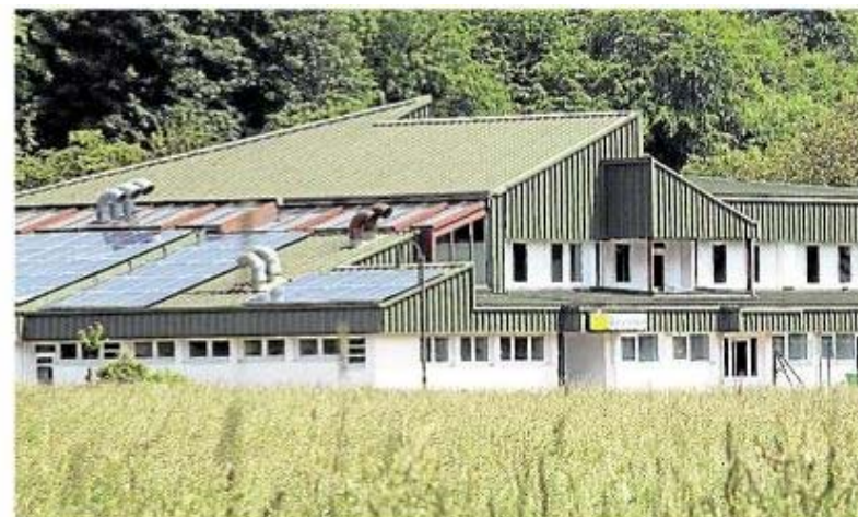
Die Fotovoltaikanlage auf dem Dach des Melsbacher Bürgerhauses hat eine Jahresleistung von 25244 Kilowattstunden erzeugt. Foto: Jörg Niebergal
