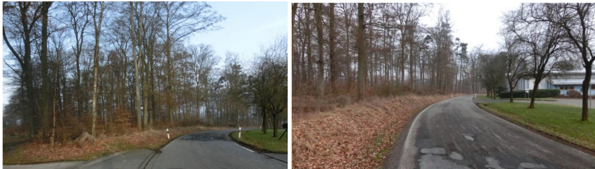
Abb.: Stand der Änderungsfläche im März 2017 (Auszug aus dem BP „Niederhonnefelder Straße“)
