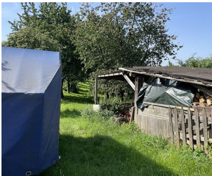
Abb.: Bestandssituation der Änderungsfläche (eigene Begehung 2024)
